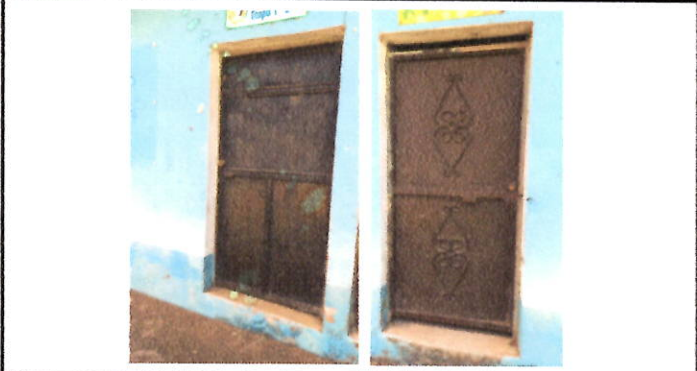
Foto1: Mantenimiento a puerta metálica existente retiro de óxido, suciedad y pintura deteriorada; incluye cepillado, lijado y aplicación de pintura., dos de cocina y comedor y tres de módulo de aulas incluyendo
