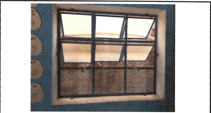
Foto 2: Sustitución de ventanas; sistema de apertura: Corredizas, Perfiles color blanco estandar, Material del marco: PVC Material de la ventana: Vidrio, sellado perimetral.
