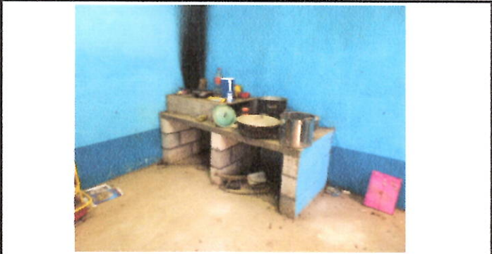
Foto 5: Reparación de área de cocina a refuerzo a polletón existente y sustitución de estufa rural con chimenea, plancha y acceso
