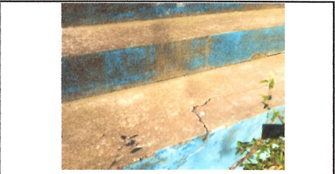
Foto 6: Reparación de losa de concreto para patios, considerando preparación de terreno, armado, nivelación, acabado rustico, incluye reparación de gradas existentes.
